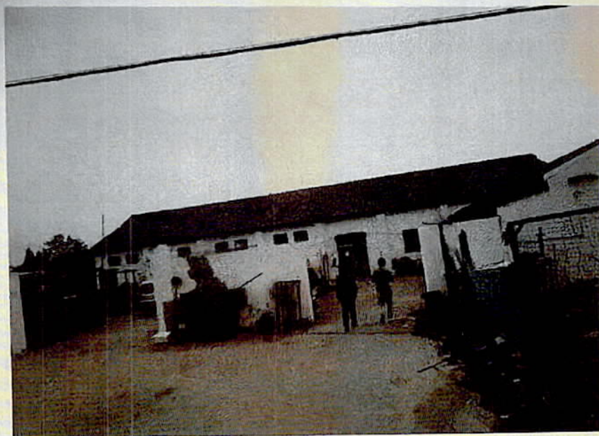
现场勘查照片
